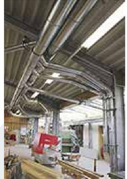
Der Rückluftkanal ist innen isoliert. Das mindert sowohl den Wärmeverlust als auch den Schallpegel.
